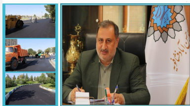
اجرای 75 هزار مترمربع عملیات آسفالت مکانیزه معابر شهر حسن آباد در سال 1403
